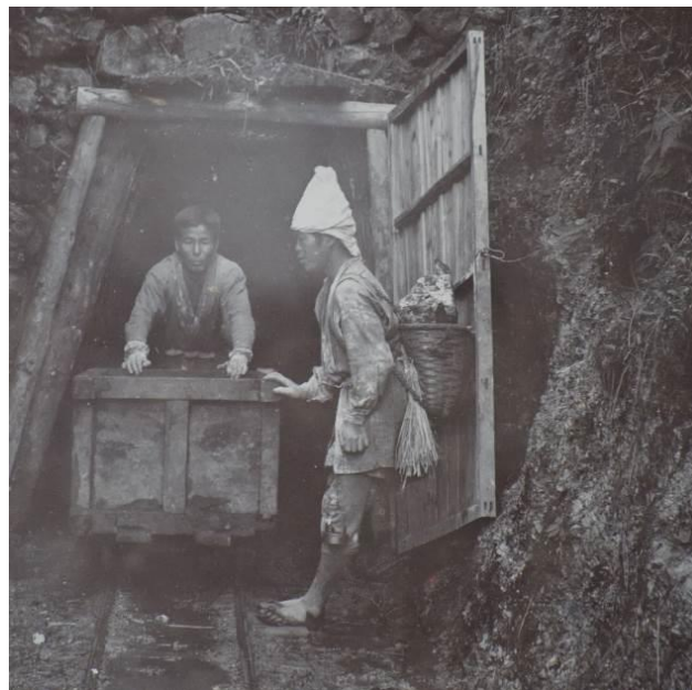
金山坑口からトロッコで運び出される金鉱石
